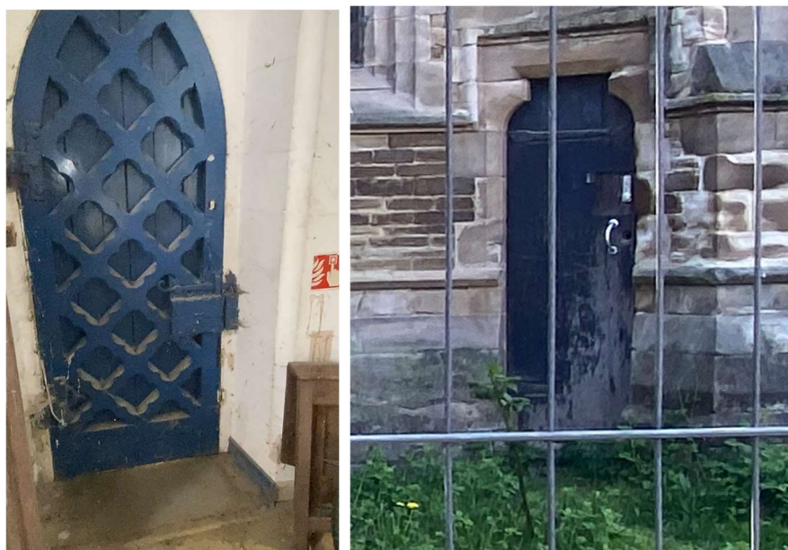
Fig 19 & 20 external side door and basement door
