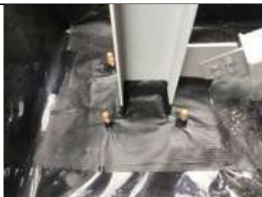
Stanchions sealed using Juta GP1 SAM
