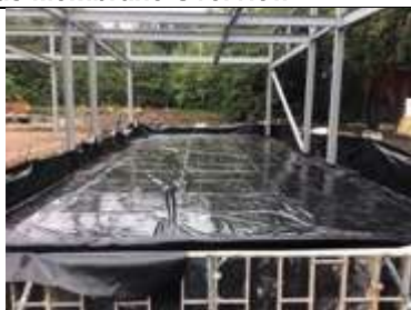
Overview of pour 1a line out installation
