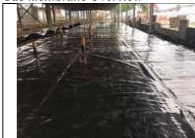
Overview of the pour area installed
