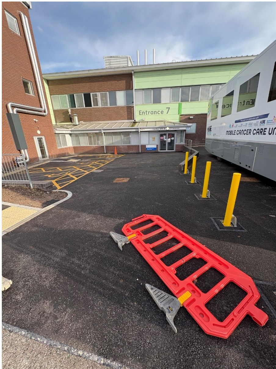
SITE PHOTOS JAN 2026
