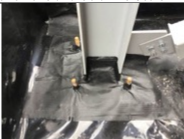
Stanchions sealed using Juta GP1 SAM
