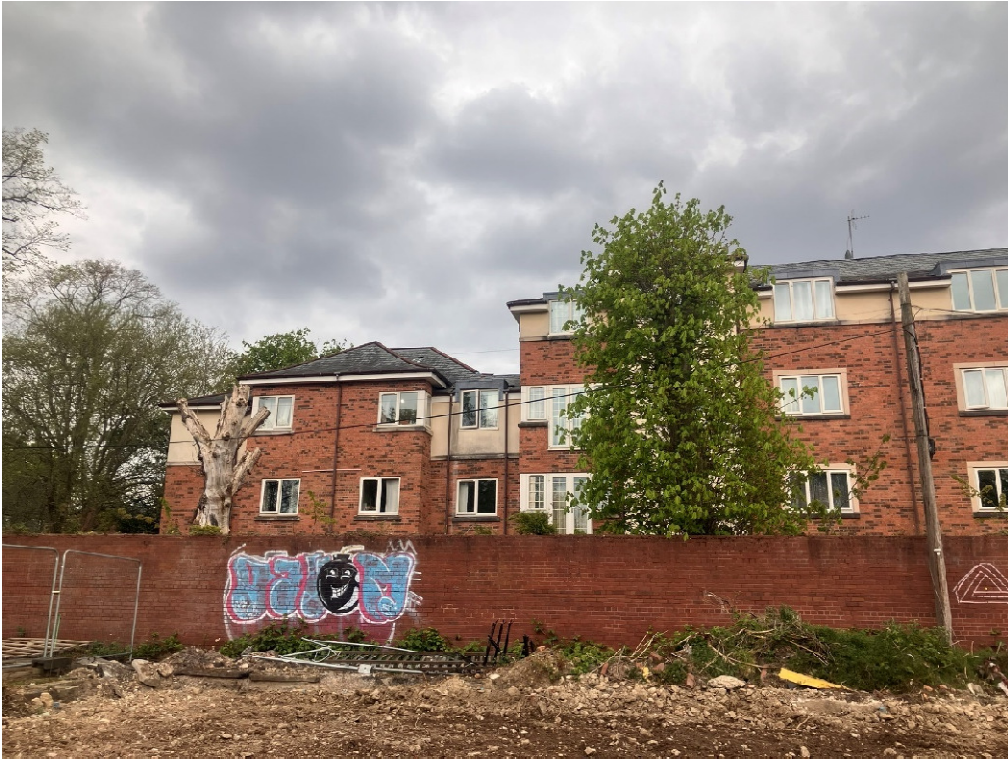
P09A (Wall W13)
