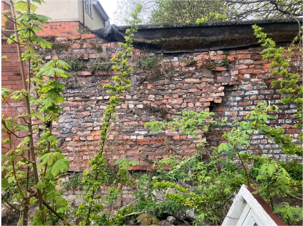
P12A (Wall W14)
