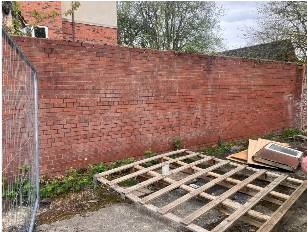
P10A (Wall W13)
