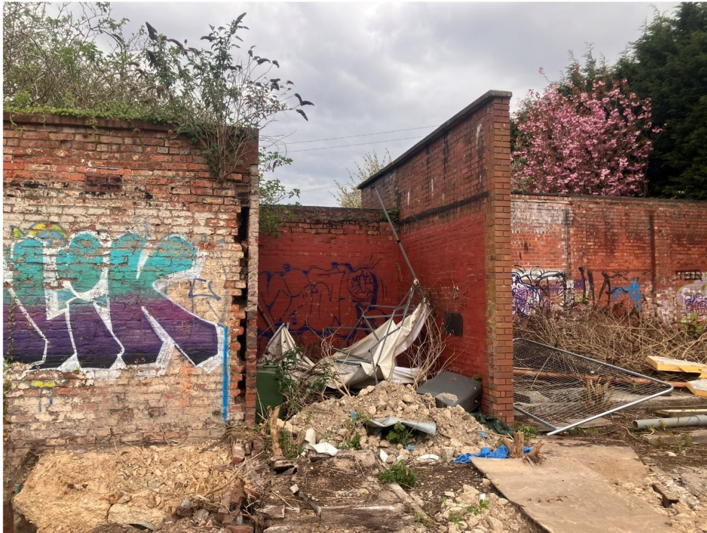
P03A (Walls W05& W06)
