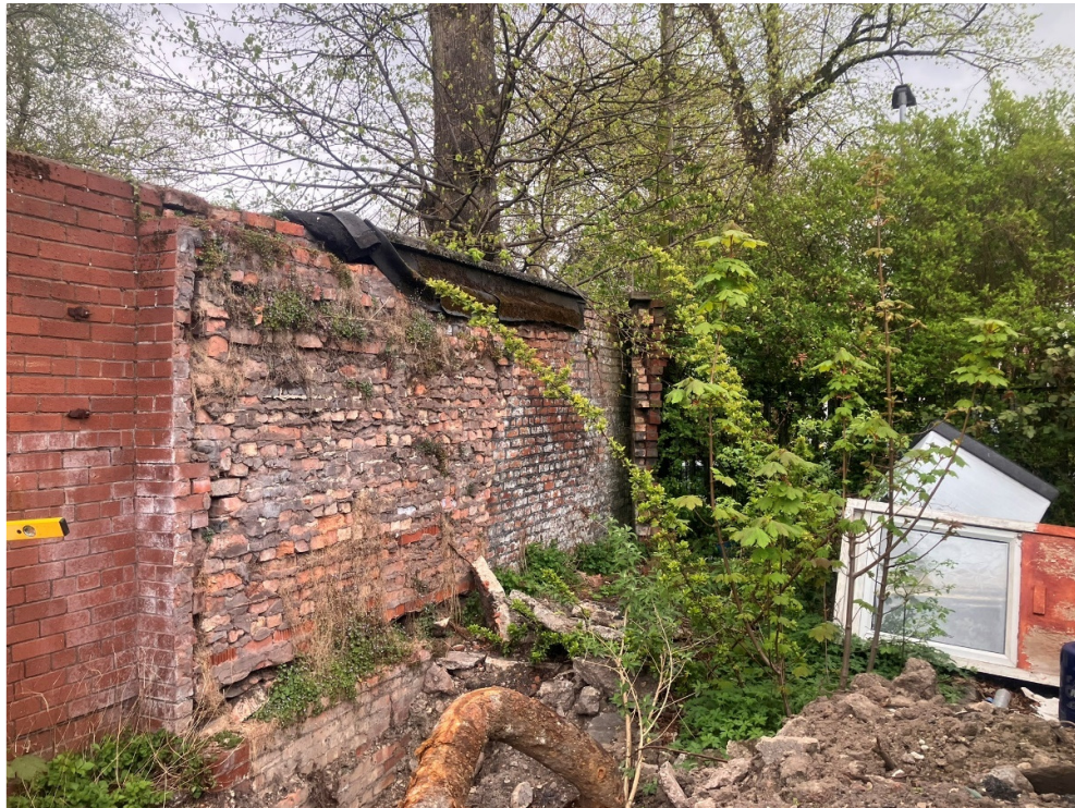
P11A (Wall W14)
