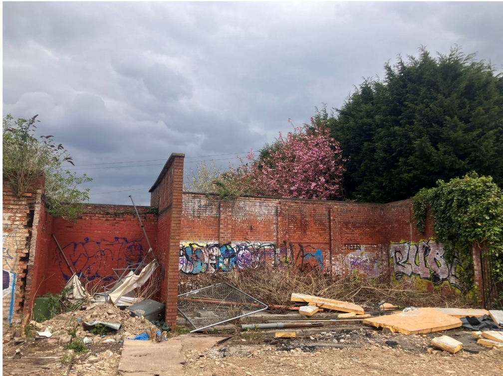
P04A (Walls W04, W05 & W07)
