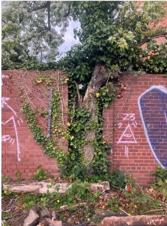
P07A (Wall W12)
