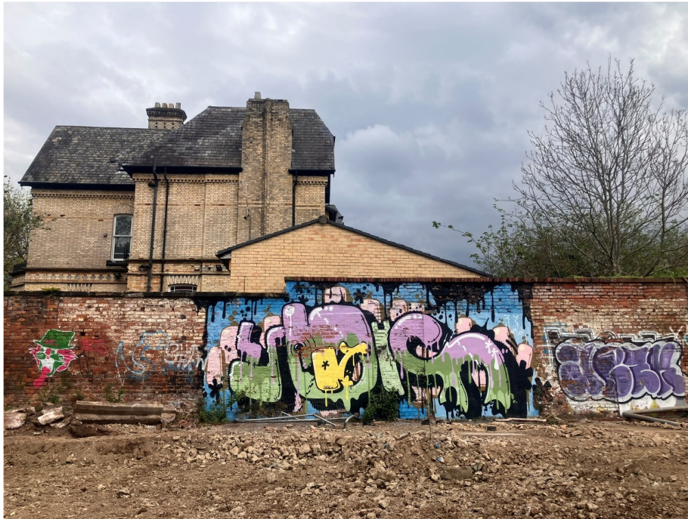
Photo P02A (Wall W02)
