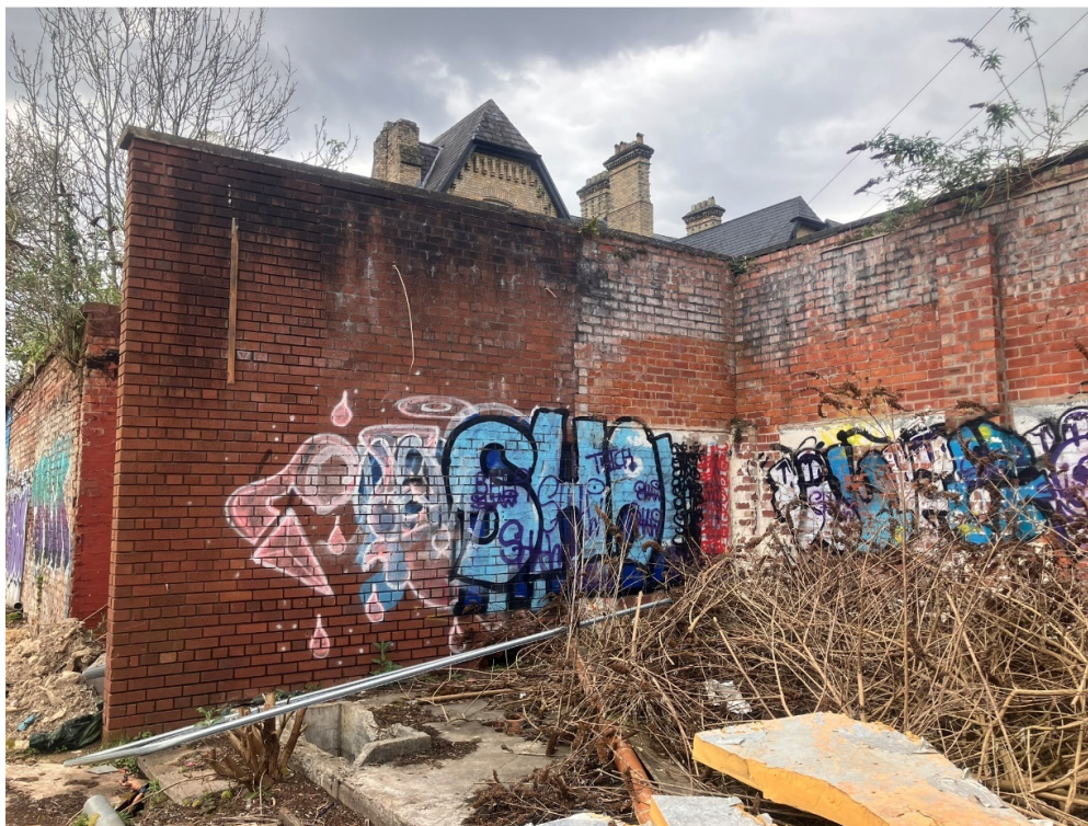
P05A (Walls W05, W06 & W07)
