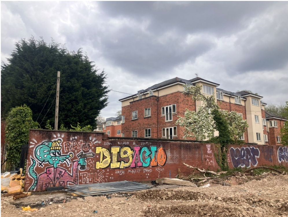
P06A (Wall W12&W13)
