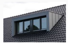
Metal clad dormer
