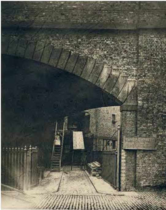
A - 1906 - Altrincham St
