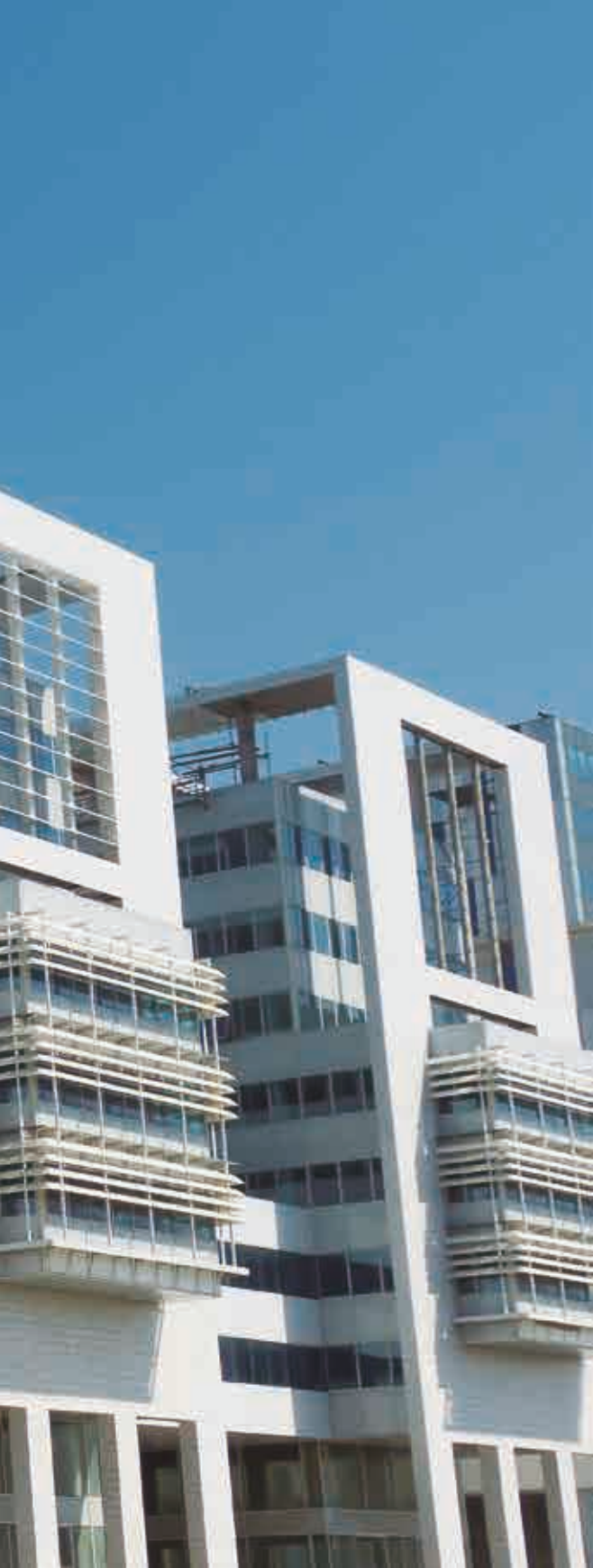
Proyecto/ Project : La Marina. Casablanca (Morocco)
