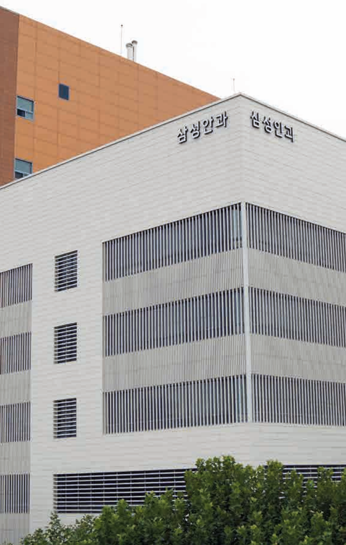
Proyecto/ Project : Samsung Hospital. South Korea
