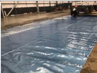
Membrane lined ahead of the pour
