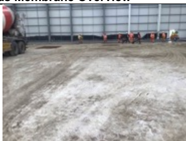
Overview of the pour area
