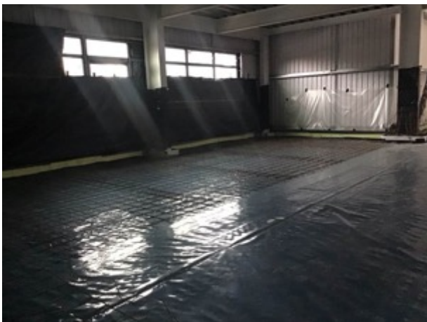
Membrane lined ahead of the pour
