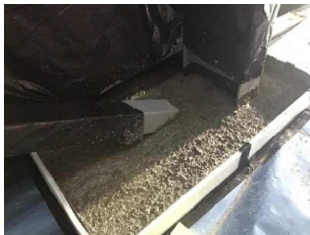
Stanchions encased prior to the pour inspection
