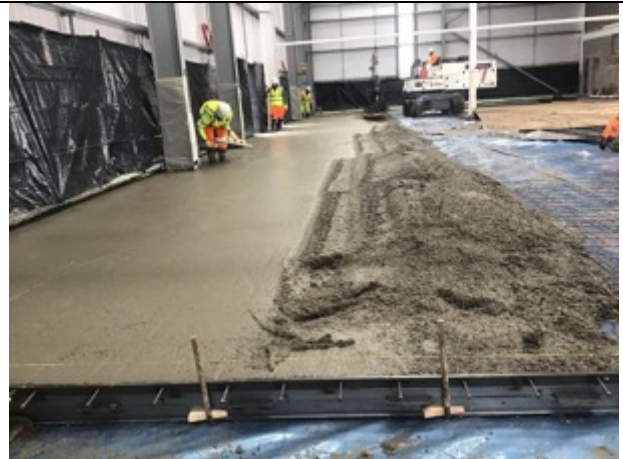
Laser screed pour
