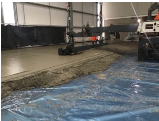
Laser screed pour
