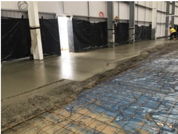
Laser screed pour
