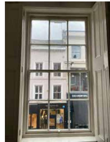
Plate 3.4.72 F.01 Sash window
