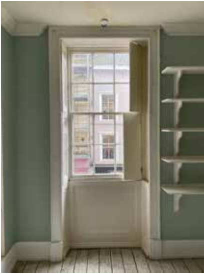
Plate 3.4.112 F.05 Sash window
