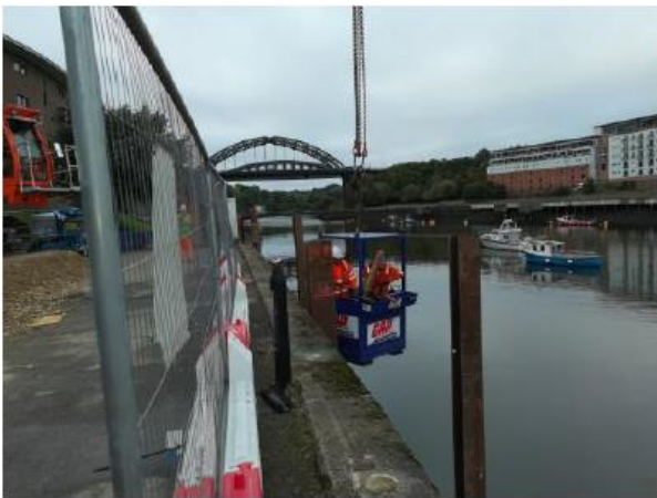
Spud pile installation
