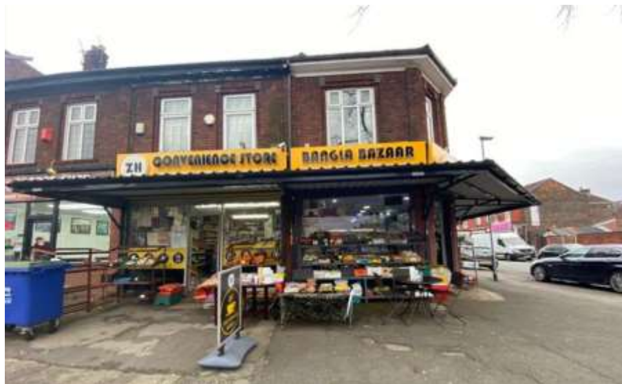
Nos. 338-340 Dickenson Road
