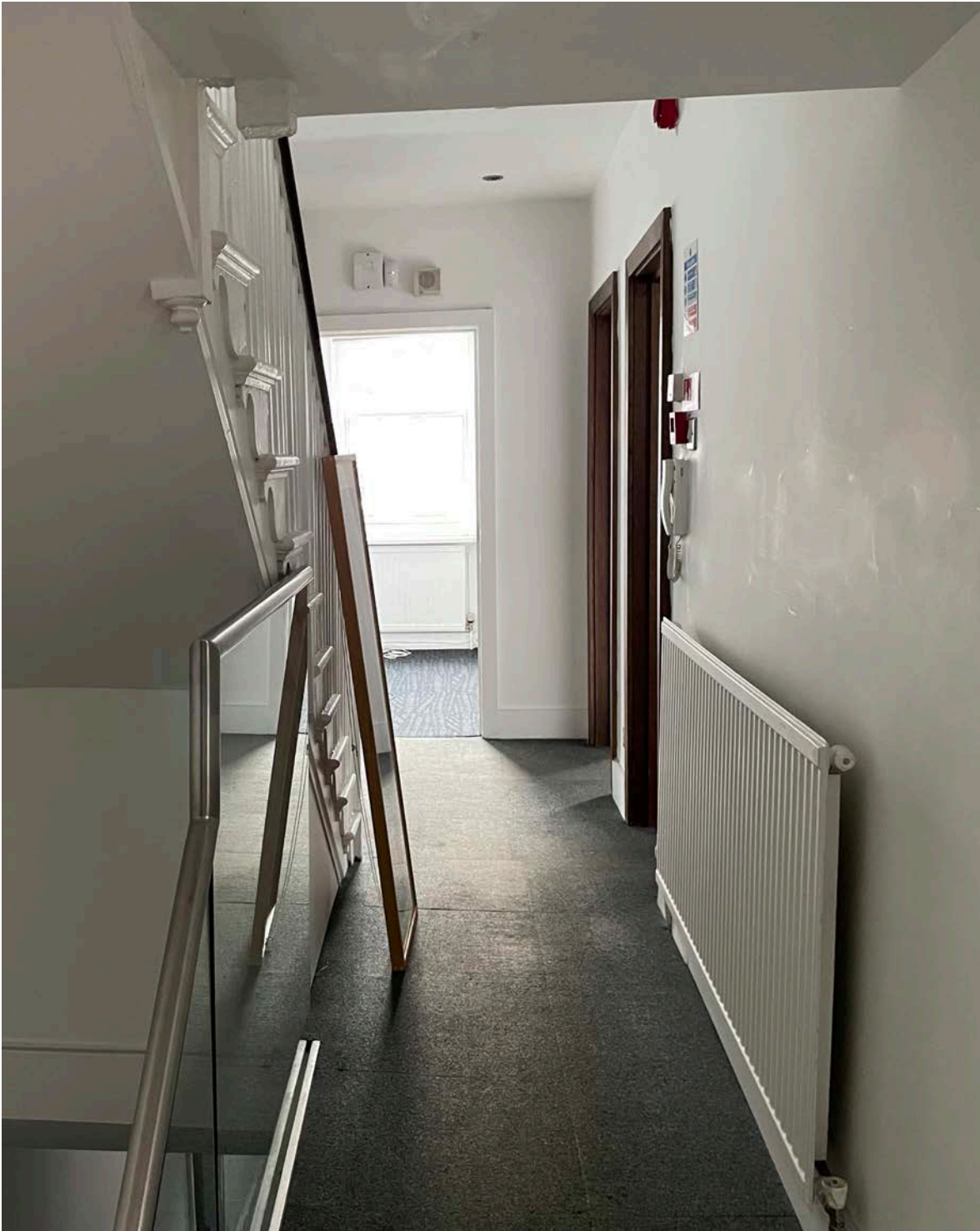
Print Room - Existing door Dem.35 / 40
