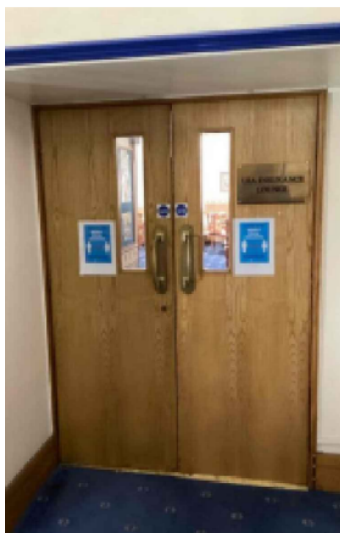
Existing double door
