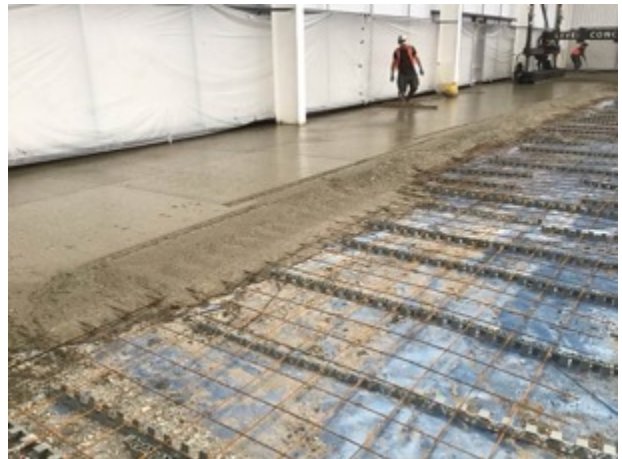
Laser screed pour
