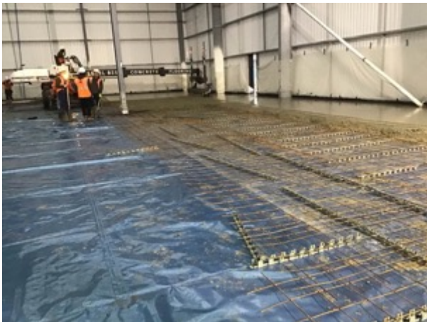
Laser screed pour
