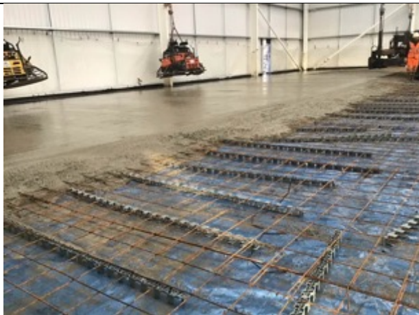
Laser screed pour
