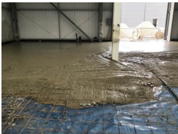
Laser screed pour
