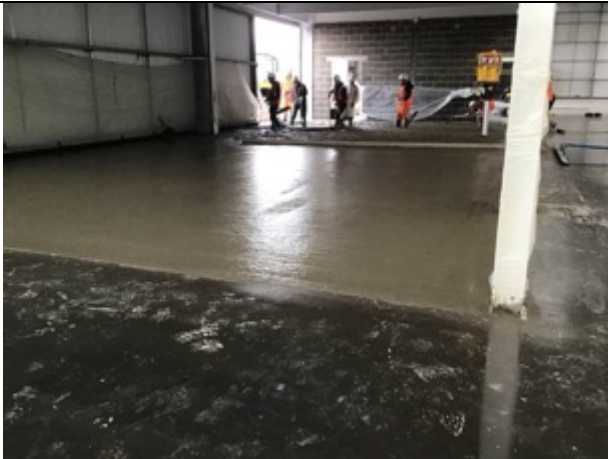
Under Croft area pump pour
