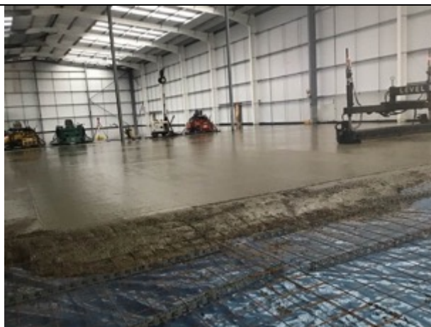
Laser screed pour
