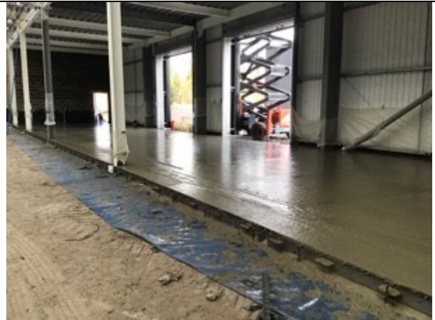
Laser screed pour
