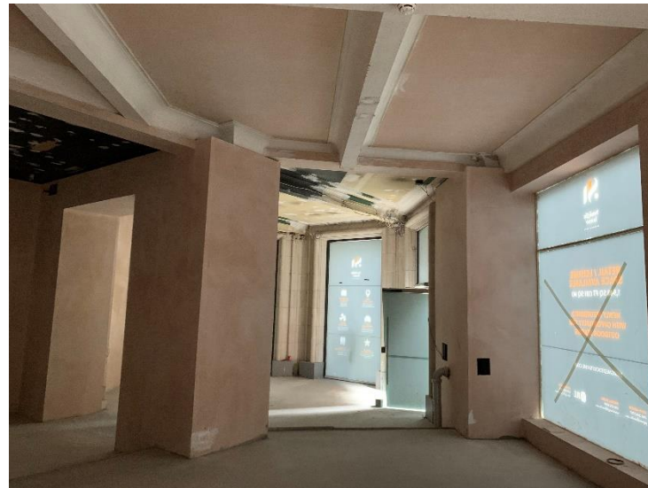
Existing plastered unit.
