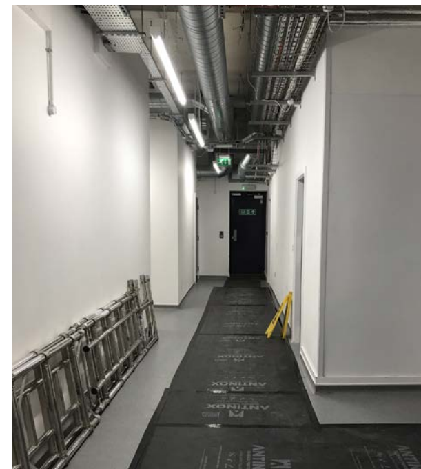
Existing GF corridor
